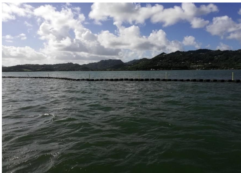
Photo n° 1 : Barrage flottant anti-sargasses bloquant
